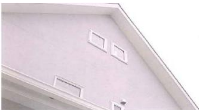
図 2.29 石綿含有スラグせっこう板の施工例（左）と建材の近撮（右）
