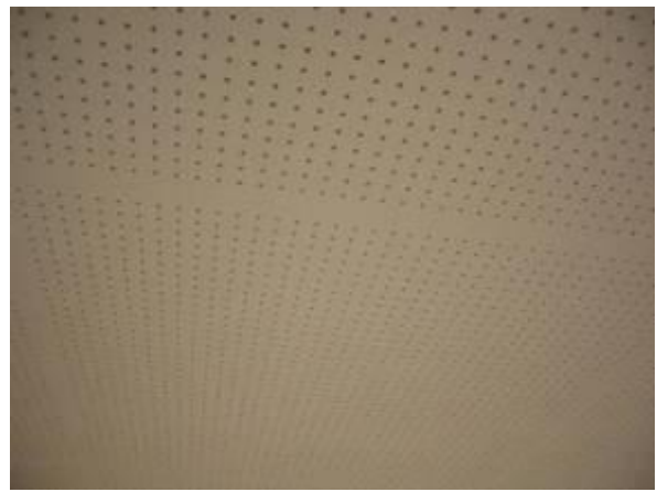
吸音用孔あき石綿セメント板
