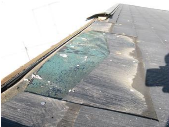
図 2.35 石綿含有ルーフィングの施工例
