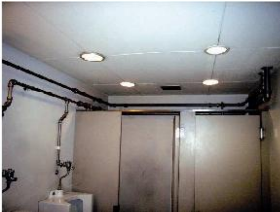
天井のフレキシブル板
