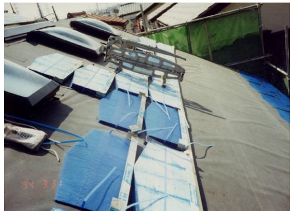
図 2.35 石綿含有ルーフィングの施工例
