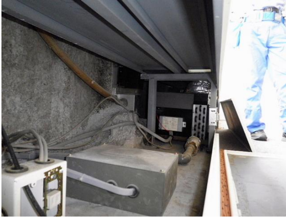
図 2.20 ペリメータカウンター内部の吹付けロックウール
