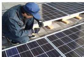
太陽光発電システム施工実習 （住環境計画科）
