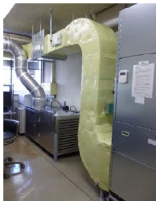
機器分析室 改修
