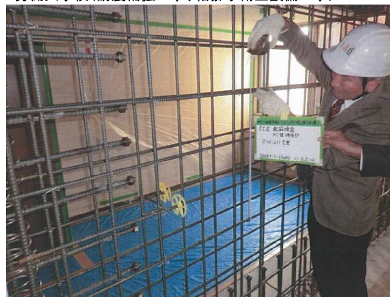
※写真は耐震補強工事の様子。
