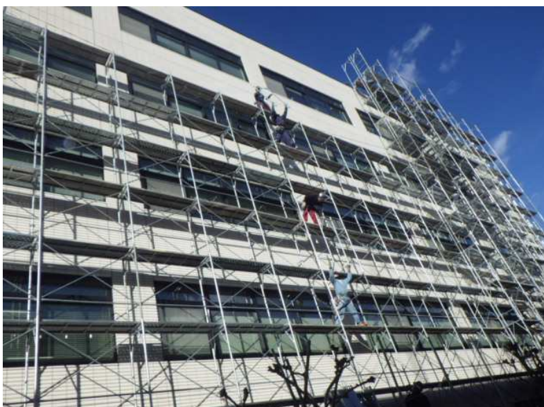
※写真は建築工事の様子。
