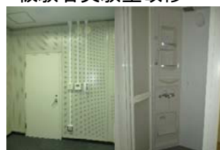
被験者実験室改修
