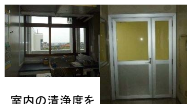
室内の清浄度を 維持するために 建具の更新
