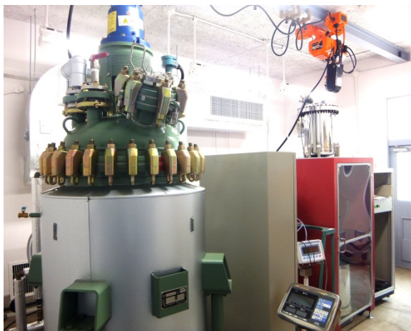
液体攪拌帯電 実験室改修
