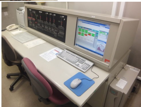
中央監視装置改修
