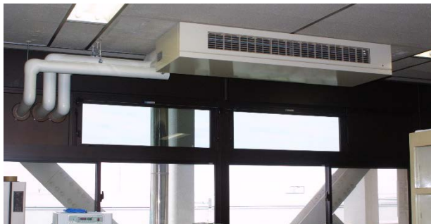
冷暖房設備 改修
