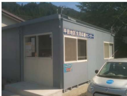
新築された平田地区生活応援センターの外観
