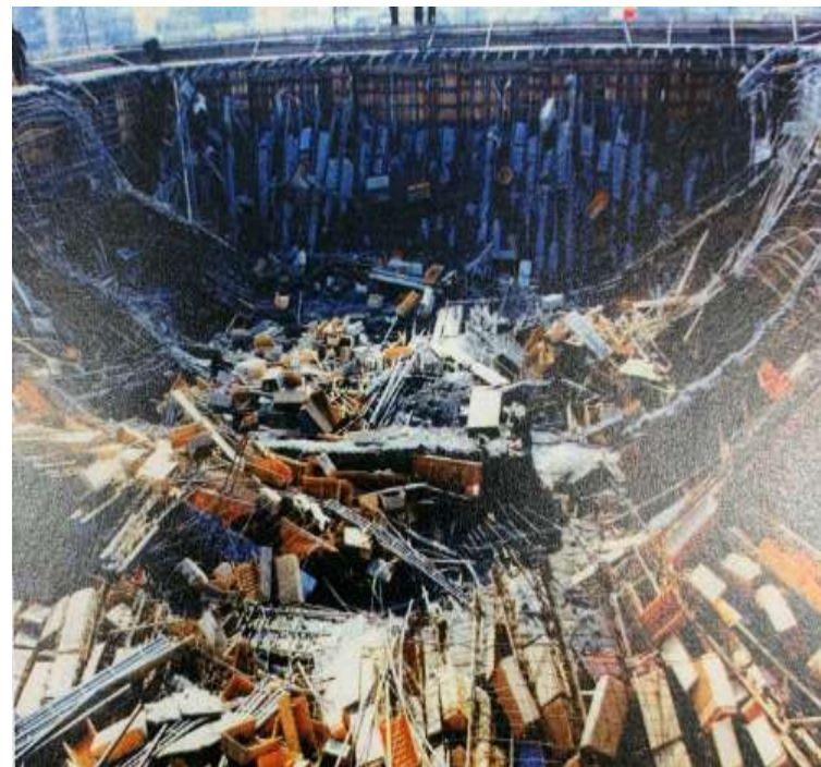
建設現場での崩落災害現地調査風景(参考)
