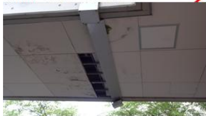
天井落下(2階渡り廊下の床裏)
