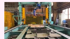
溶接ロボット
