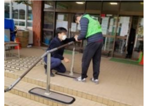
転倒防止など避難所の環境整備
