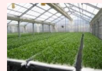
農業生産施設（水耕栽培ハウス）
