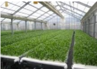
農業生産施設 （水耕栽培ハウス）
