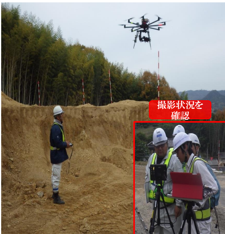
ドローンを使った測量風景
