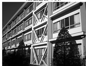
(耐震整備の例)
