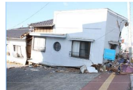
建物の全半壊が多く見られた（小高区）
