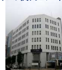
尾上町交差点角 リスト関内ビル6階
