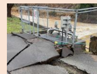
水道の復旧 (被災した浄水場)
