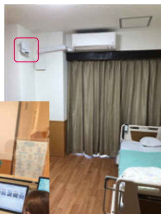
設置されている機器（左上）
