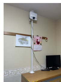
施設居室内への 機器の設置
