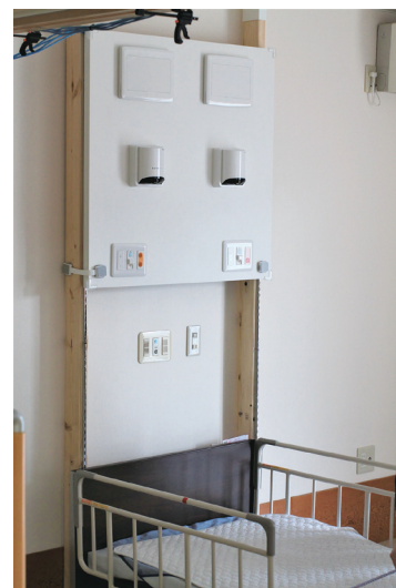
居室への機器設置の様子
