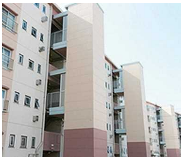
中層住棟に設置したエレベーター（相模台/神奈川県相模原市）
