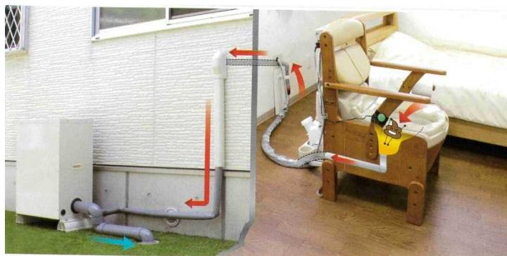
図8.1 真空ポンプ式のポータブルトイレ
