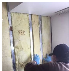
例：壁の防音改修
