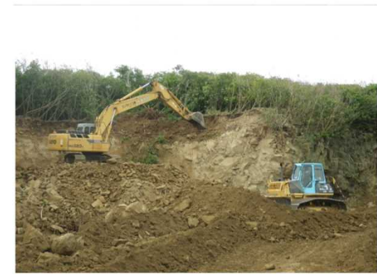
重機による掘削
