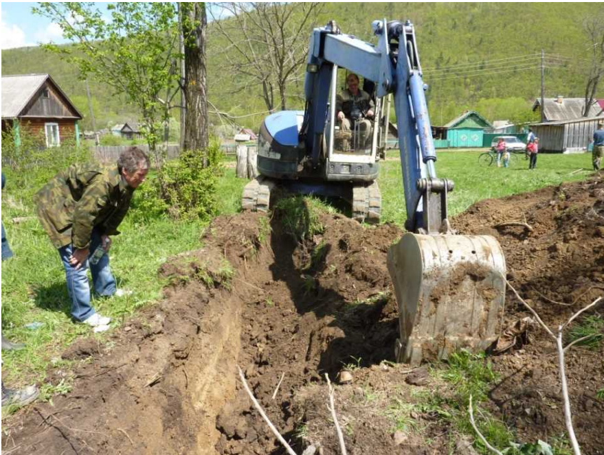
重機による作業
