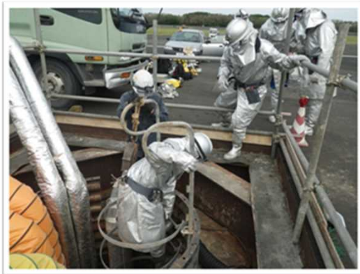
壕内が高温のため、防火服を着用
