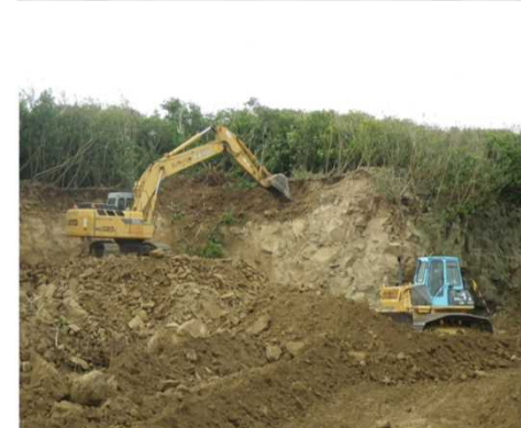
重機による地下壕調査
