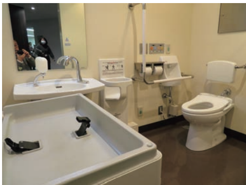
障害者用トイレ
