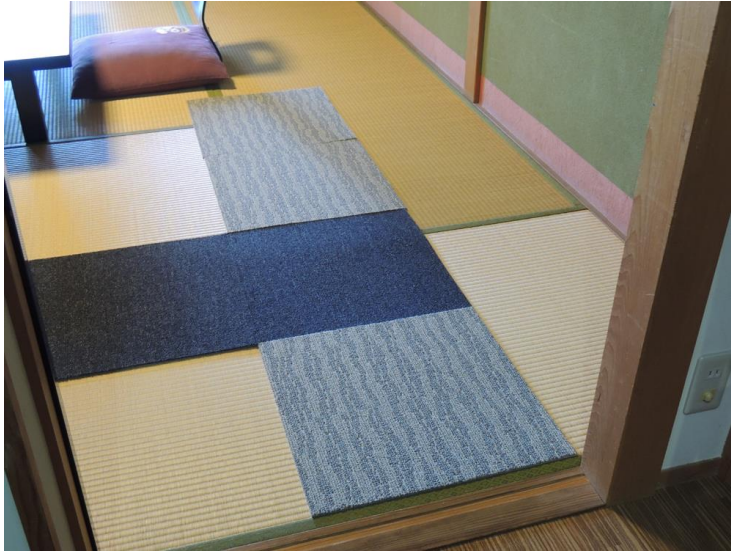
電動車いすでも気兼ねなくご利用いただけるよう、タイルカーペットを畳の上に敷いて対応した。
