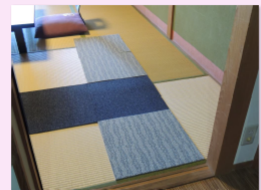
電動椅子でも気兼ねなくご利用いただけるよう、タイルカーペットを畳の上に敷いて対応した。
