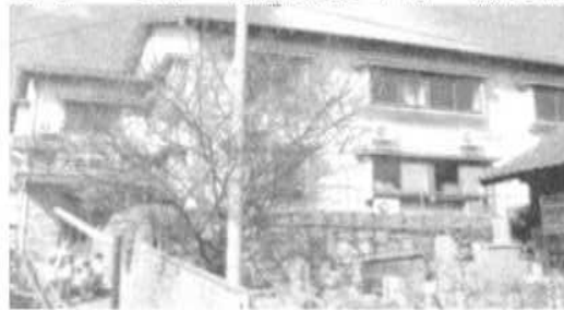
改造が進む旧大丸旅館 (下関市竹崎町で)
