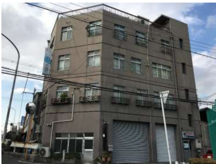
外観。このビルの2階の一室にある。
