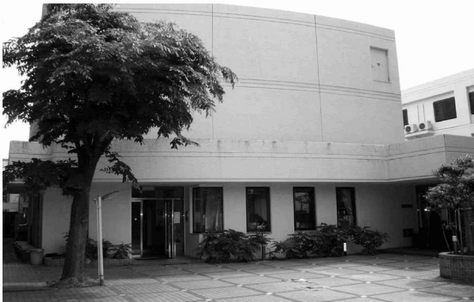
更生保護施設 盟親 外観(京都市中京区)
