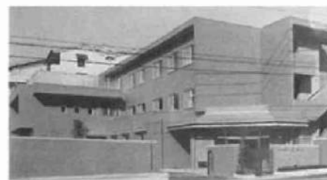
更生保護施設の外観
