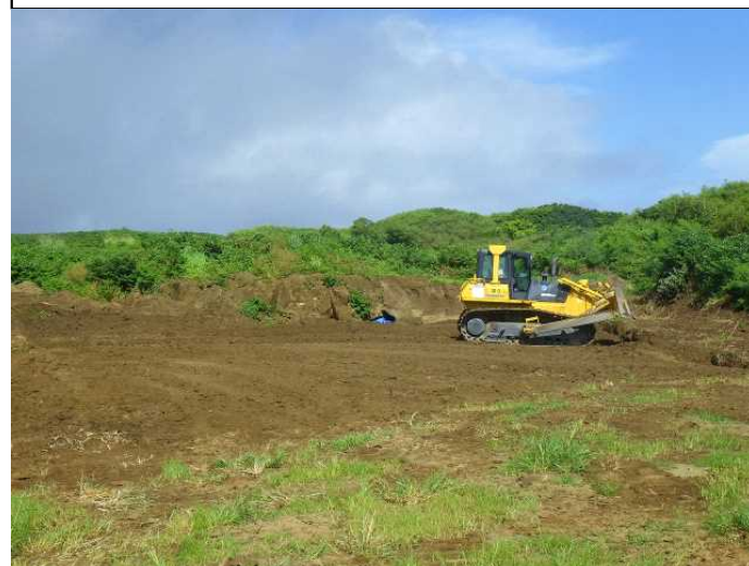
④埋戻し・整地作業
