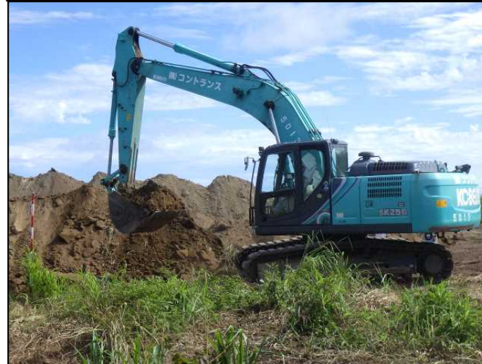
②掘削作業
