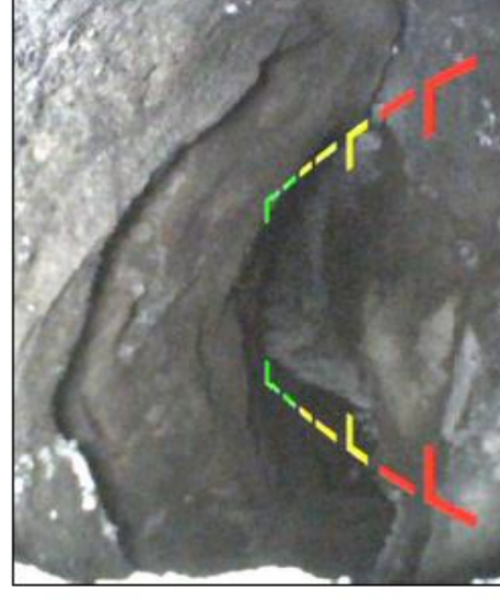
CCD画像 (南側方向) 地下壕は南側に開けており、天端は連続している
