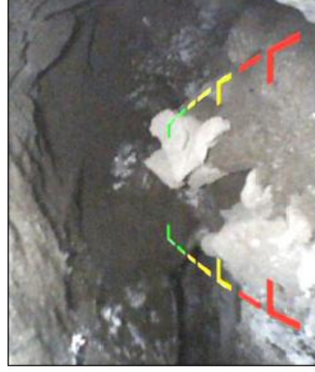
CCD画像 (北側方向) 地下壕は北側に開けているが崩積土が多く堆積
