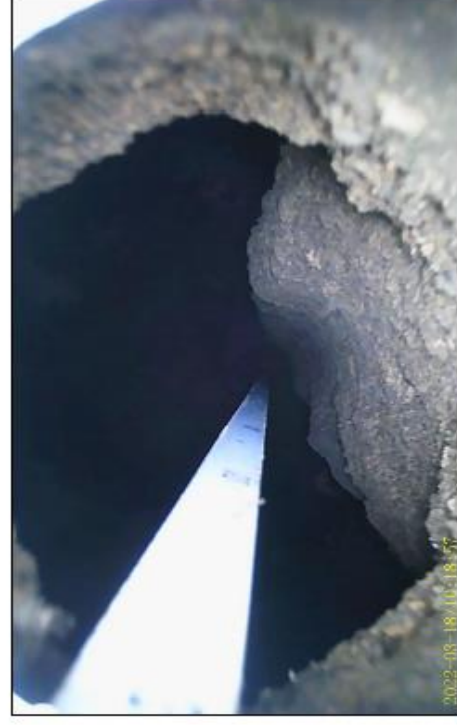
CCD画像 (鉛直方向、GL-18.5m付近) ボーリング孔は地下壕壁面をかすめるように掘削されている。
