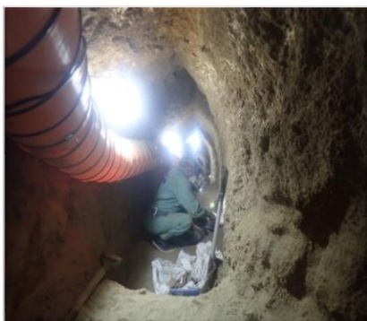
①地下壕の様子
