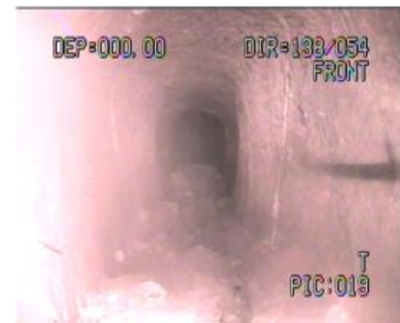
地下壕①の状況
