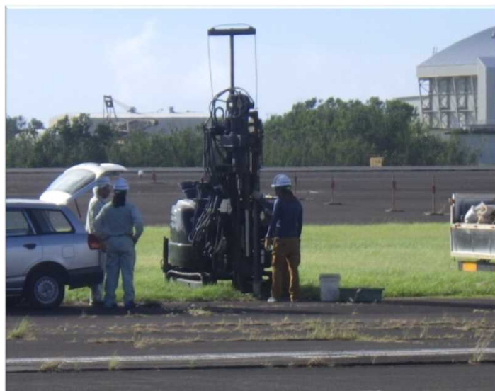
ボーリング調査の様子
