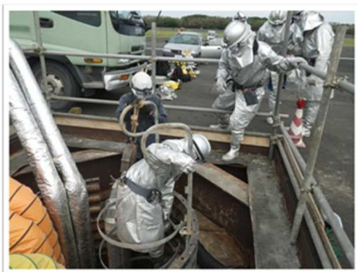
壕内が高温のため、防火服を着用
