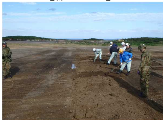
掘削した土砂を仮置き場で確認
