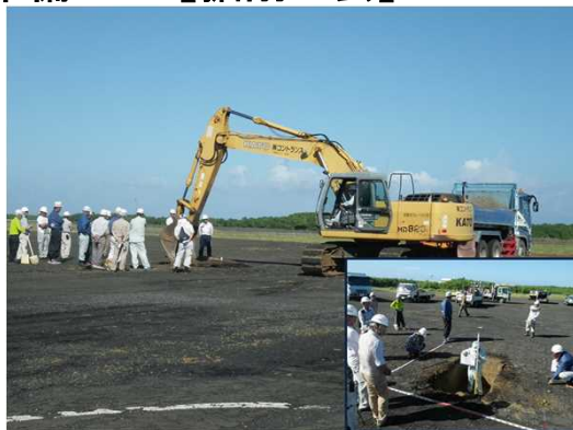
レーダ探査反応箇所の掘削
