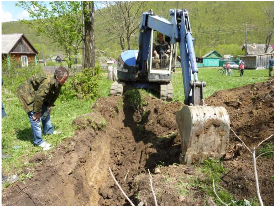
重機による作業
