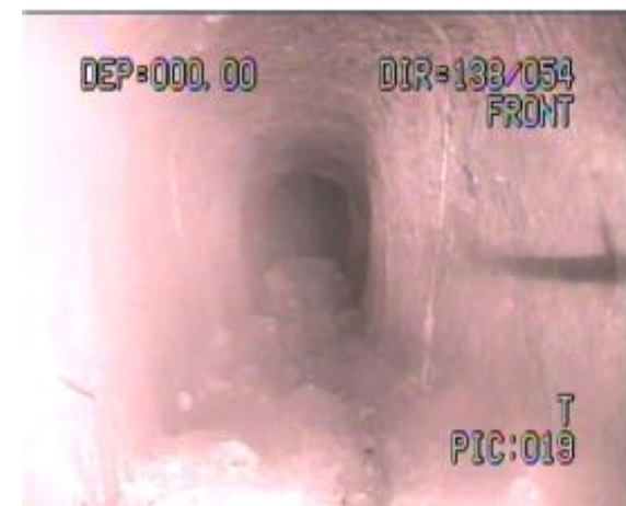
地下壕①の状況
