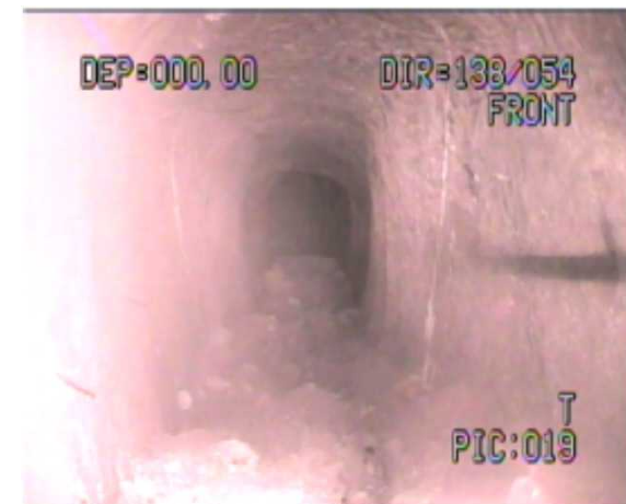
地下壕①の状況
