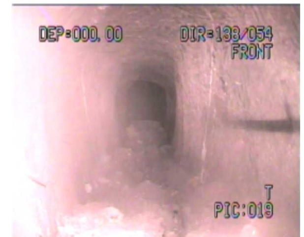
地下壕①の状況
