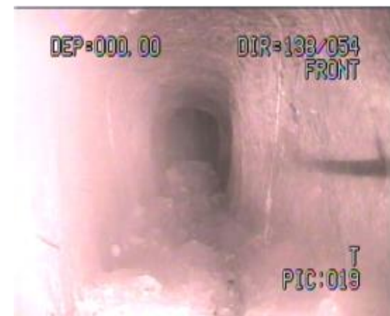
地下壕①の状況
