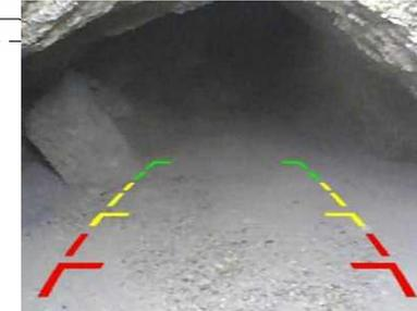
写真3 B1-19空洞状況深度2.9m
