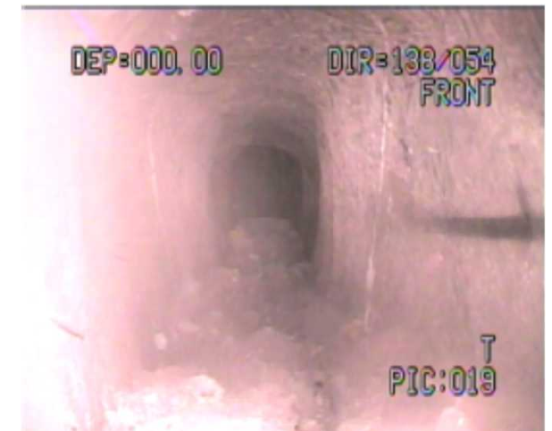
地下壕①の状況
