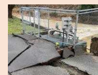
水道の復旧 (被災した浄水場)
