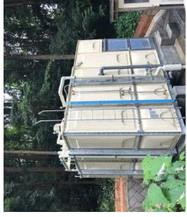
給水設備（受水槽）の例
