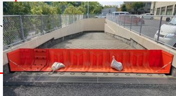
【地下行き外スロープ】
