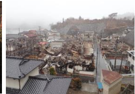
綾里港地区の被害状況
