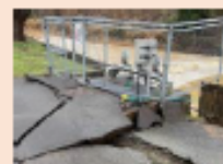
水道の復旧 (被災した浄水場)
