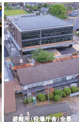
避難所（役場庁舎）全景
