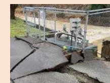
水道の復旧 (被災した浄水場)
